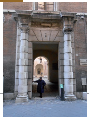
Giovanni Laurentini Arrigoni (attribuito), il portale a due ordini sovrapposti, rustico militare e a colonne fasciate toscane con trabeazione.
